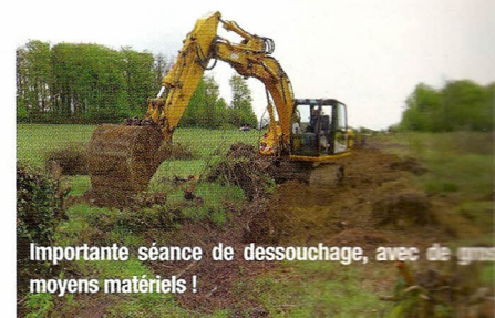
La friche d'origine du futur terrain ouvert en 2015.
